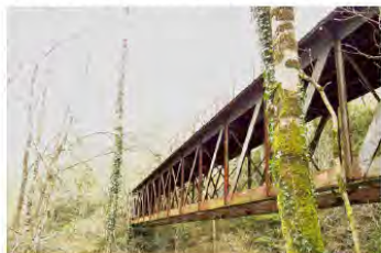
Pont de Rebaut (de type Eiffel)
