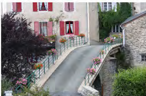
Le Pont Vieux
